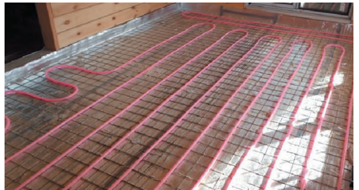
Опалення будинку з бруса, монтаж системи
