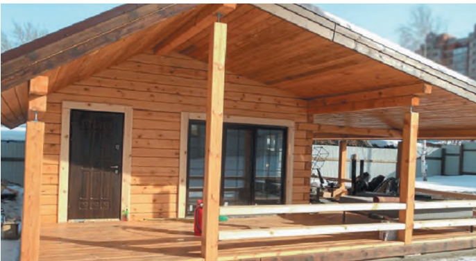
Опалення будинку з бруса, вид на об'єкт
