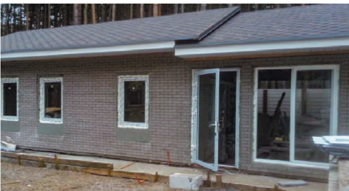
Опалення будинку з пінобетонних блоків, вид на об'єкт
